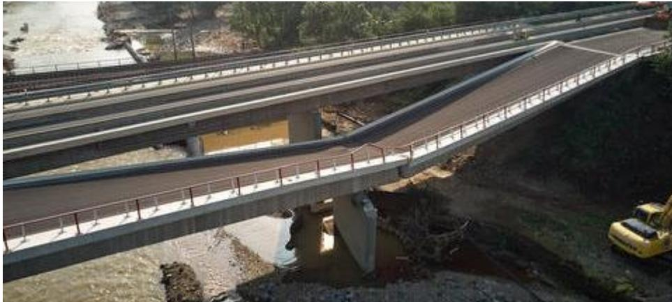
Abbildung 13: Einsturz der Ahrbrücke<sup>17</sup>
