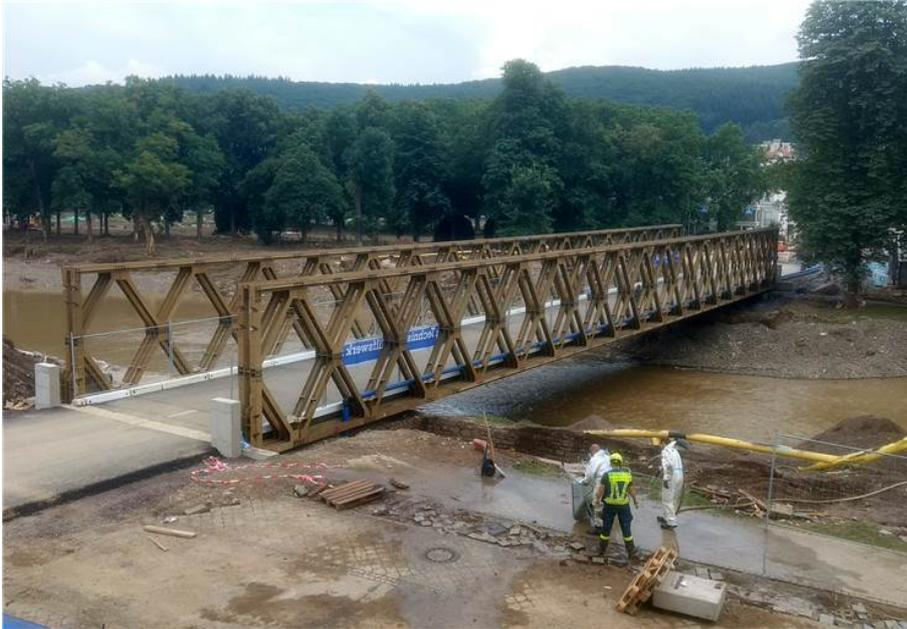
Abbildung 5: Behelfsbrücke an der Landgrafenbrücke
