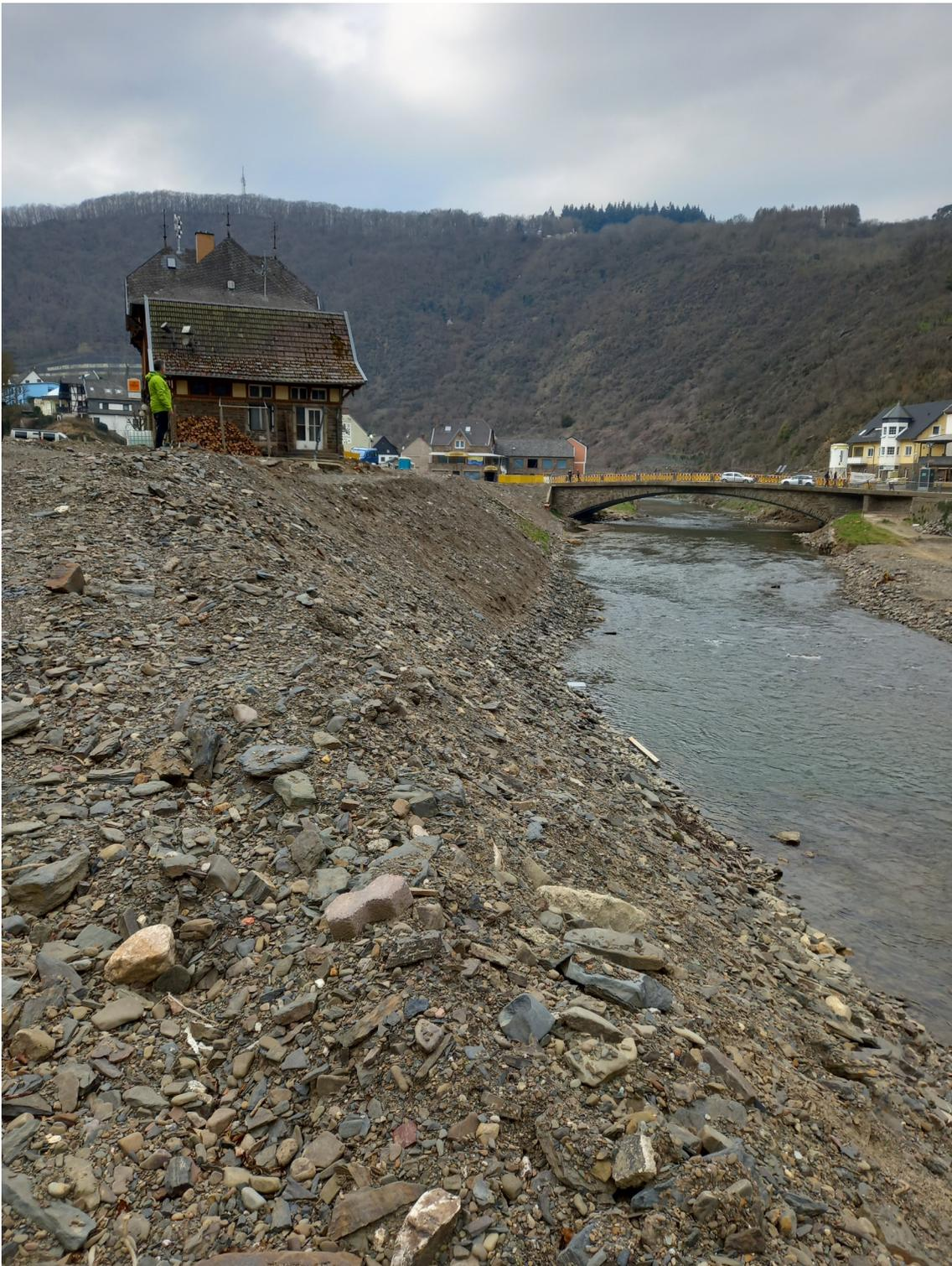
In Altenahr hat sich die Ahr durch das Hochwasser sehr stark in die Ufer gefressen und hat praktisch jeglichen Bewuchs entfernt, einschließlich mehrerer Bäume von über 5 Meter Höhe. Kurz hinter dem Bahnhof zerstörte die Ahr sowohl die darüber führende Eisenbahn-als auch die Fahrradbrücken, deren Trümmer dann teilweise in der direkt dahinter liegenden Kurve wieder abgelagert wurden. Auch hier wurden die Ufer
