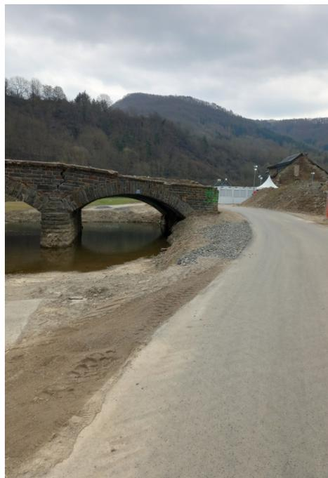
An der Brücke wurde das Wasser jedoch gestaut und umgelenkt, was zu starker Uferzerstörung führte und jene abrupt abfallen lässt. Die Brückenpfeiler der B257 sind ebenfalls deutlich gezeichnet, die dem Fluss zugewandte Seite ist weitestgehend freigespült worden, die darüber liegende Straße ist allerdings nicht in ihrer Funktion gefährdet und wird weiterhin vollständig genutzt.
