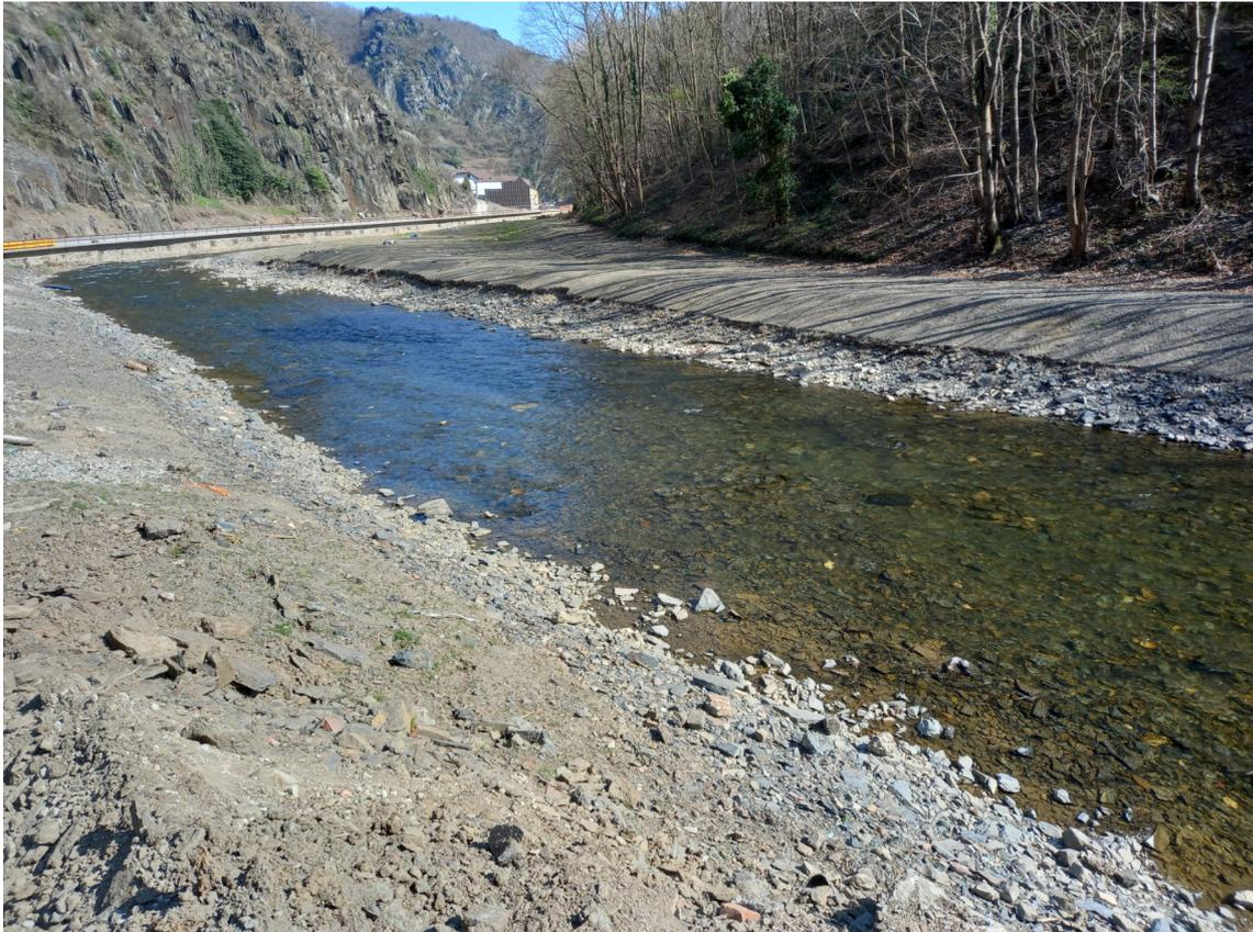
Hier war zudem ein optischer Vergleich mit einem vorherigen Hochwasser möglich. Die Bruchkante am rechten Ufer stammt von einem Wasserstand, der damals mit 2 Metern gemessen wurde. Dieser Vergleich zeigt noch einmal das Ausmaß von 2021 mit seinen ca. 7. Metern in diesem Bereich. An Straßenseite dagegen ist das Abtragen deutlich erkennbar.
