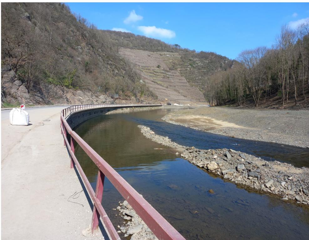
Kurz vor dem Tunneleingang bei der Kläranlage wurde das Wasser allerdings erneut eingeeengt und riss große Teile des Ufers mit sich, einschließlich des Wanderweges auf Höhe der Kläranlage. Bei der letzten Kurve am Ende des Planquadrats wurde nahezu die gesamte Vegetation entfernt, ursprünglich war es nicht möglich, vom einen Ende der Kurve zum anderen zu sehen.
